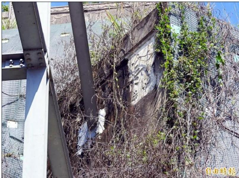
南投縣埔里鎮公所在愛蘭橋旁設置大型電子看板，其中的支撐鋼樑就直接打進舊烏牛欄橋石碑，遭質疑破壞珍貴文物。(記者佟振國攝)
