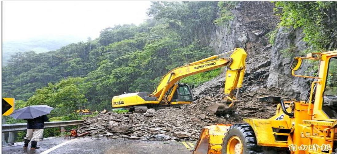
南投縣仁愛鄉台14線埔霧公路人止關路段邊坡昨天上午上班時間突然崩塌，吞沒30米路面，公路總局埔里工務段調派大型機具冒雨開挖搶通。（記者佟振國攝）
