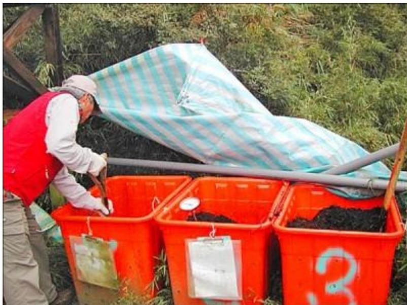
玉山主峰線生態廁所屢見亂丟垃圾，志工必須經常挾起排遺桶內的垃圾，才能維持排遺正常發酵分解。(玉管處提供)
