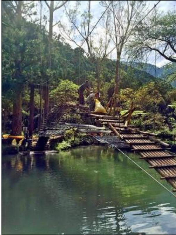
溪頭自然教育園區進行大學池竹橋翻修工程，工程人員在橋上拆除舊的竹子，並鋪設鐵片方便重新鋪設竹子。(溪頭自然教育園區提供)
